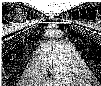
La galería de moda. Aquí se ubicarán las tiendas de ropa y complementos. Ya se están colocando las baldosas del suelo.
